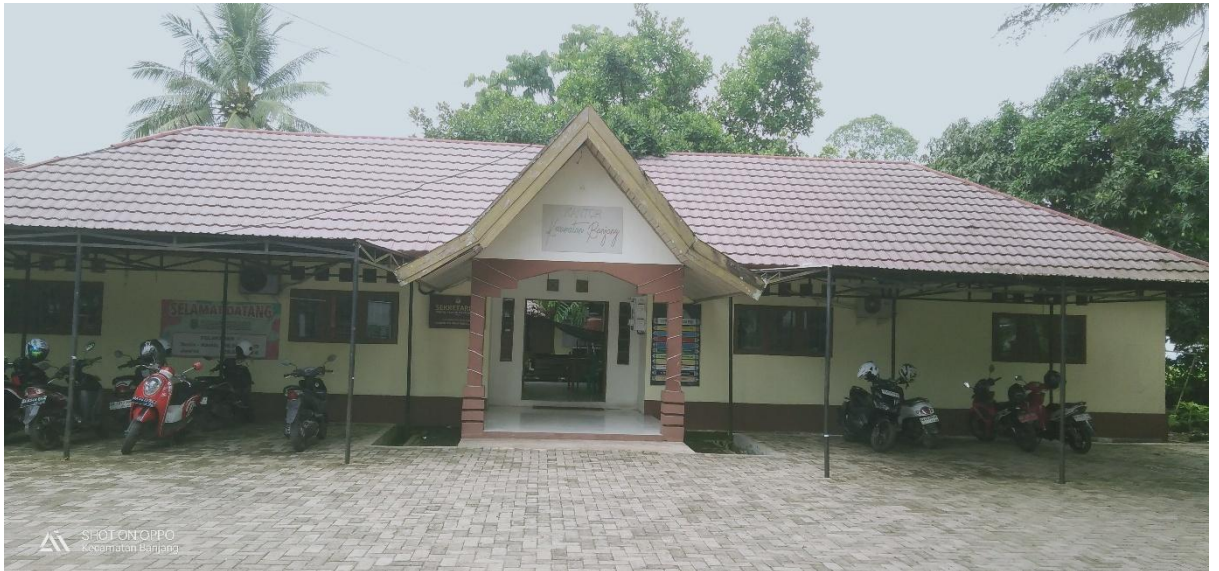
Gambar 3.1 Kantor Camat Banjang, Kabupaten Hulu Sungai Utara
