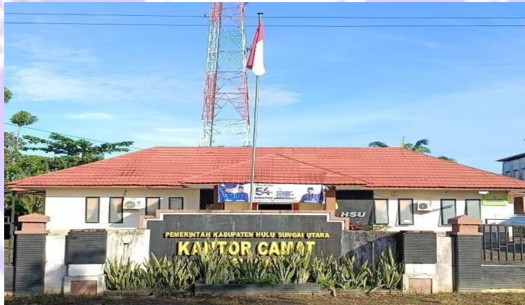
Gambar II- 1 Kantor Kecamatan Babirik Kab. Hulu Sungai Utara
