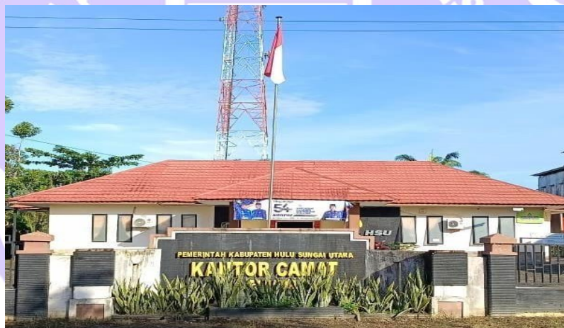
Gambar II-1 Kantor Kecamatan Babirik Kabupaten Hulu Sungai Utara
