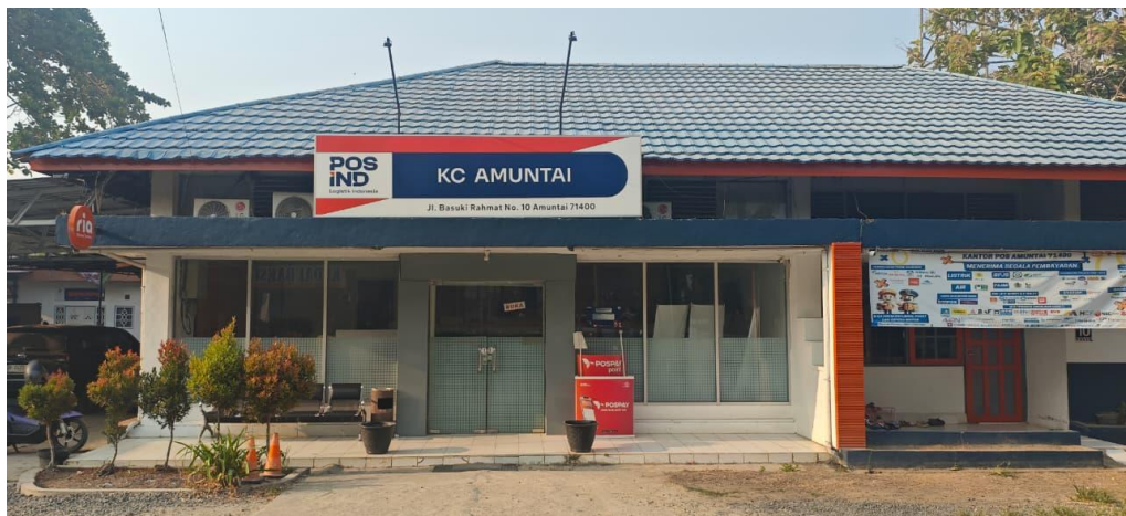
Gambar 2.1 Kondisi Kantor Pos Amuntai
