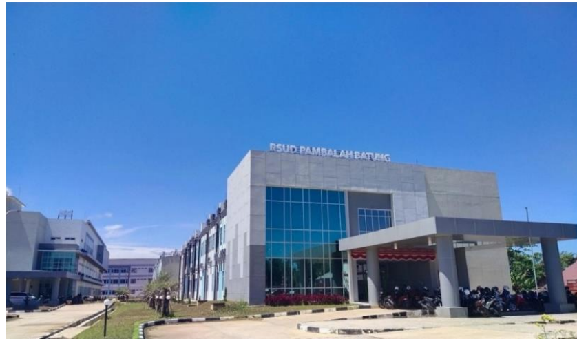
Gambar II-1. Gedung RSUD Pambalah Batung Amuntai
