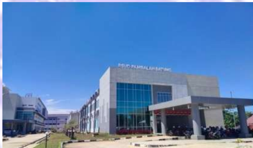
Gambar II-1. Gedung RSUD Pambalah Batung Amuntai
