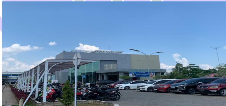
Gambar II-1. Gedung RSUD Pambalah Batung Amuntai
