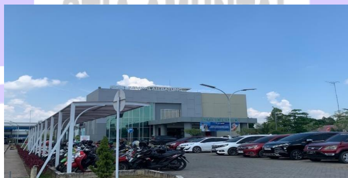
Gambar II – 1 . Gedung RSUD Pambalah Batung Amuntai
