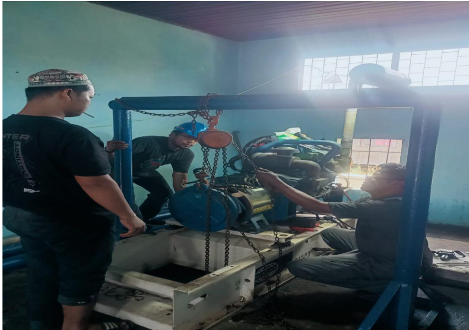
Mendokumentasikan perbaikan di Instalasi pengolah air (IPA)
