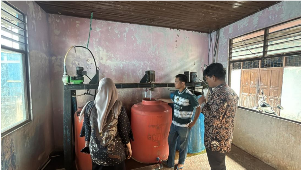
Observasi Instalasi Pengolahan Air ( IPA ) bersama operator yang jaga di instalasi sekaligus mempelejadi cara pengolahan air bersih
