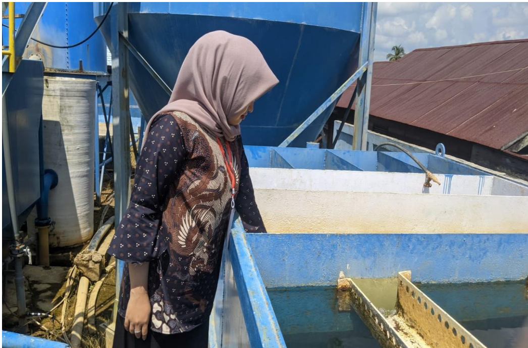
Membantu pengecekan air bersih di Instalasi Pengolahan Air ( IPA ) Tambak Bitin
