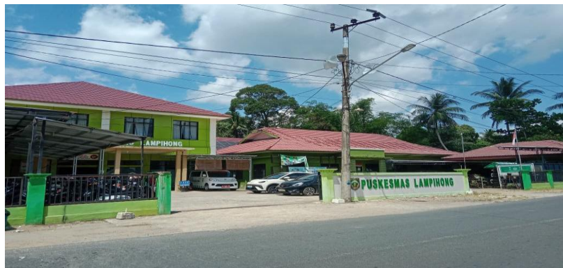
Gambar II-1 Bangunan UPTD Puskesmas Lampihong
