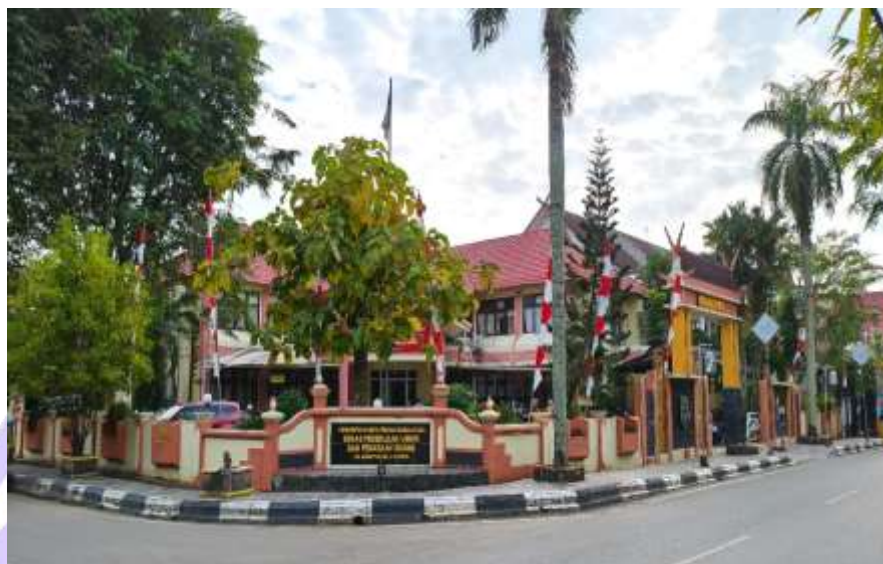
Gambar 2.1 Kantor Dinas Pekerjaan Umum dan Penataan Ruang Kab. Hulu Sungai Utara
