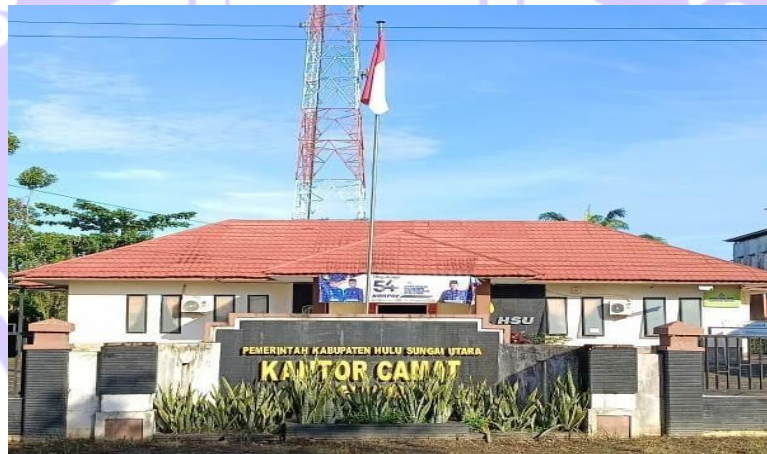
Gambar II- 1 Kantor Kecamatan Babirik Kab. Hulu Sungai Utara
