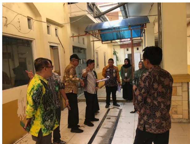
Kegiatan Pemeriksaan Bangunan Milik Pemerintah di Rumah Sakit Pembaluh Batung Amuntai yang Lama.
