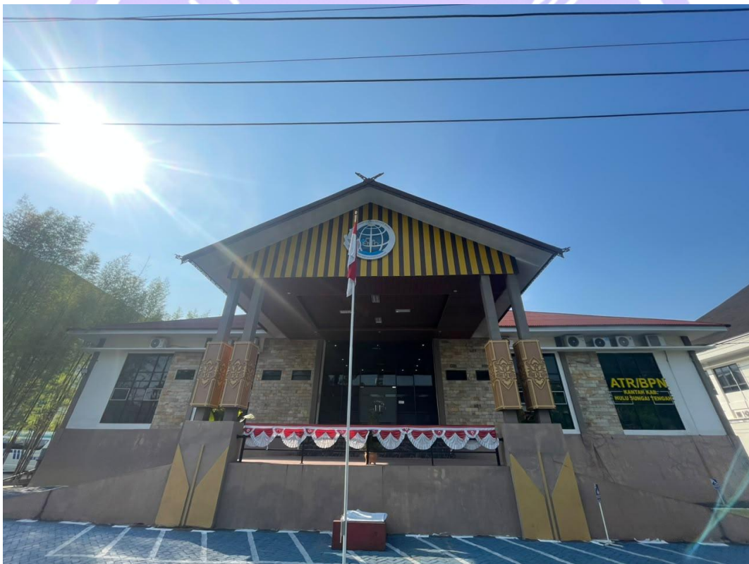
Gambar II.1 Kantor Pertanahan Kabupaten Hulu Sungai Tengah.
