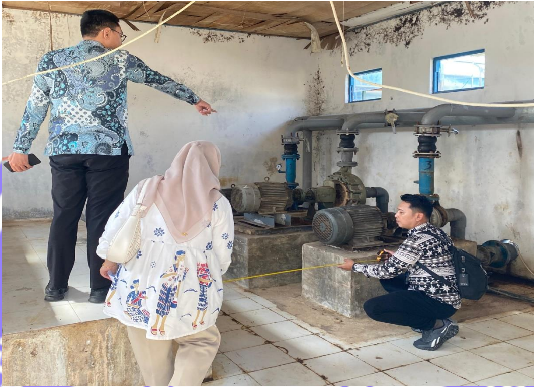
Gambar : Membantu mensketsa terkait penanganan usulan rehabilitasi /peninggian bangunan,pelafon dan pengecatan instalasi pengolahan air(IPA) Tangkawang
