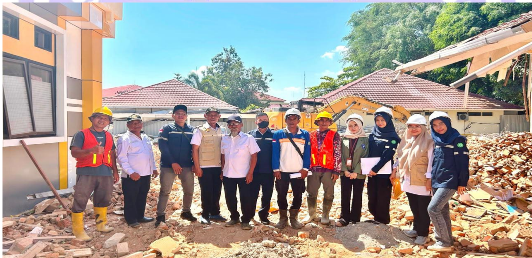
Gambar 2 Survey Pengawasan Penyelenggaraan Jasa Konstruksi RSUD Yang Lama Kec.Amuntai Tengah
