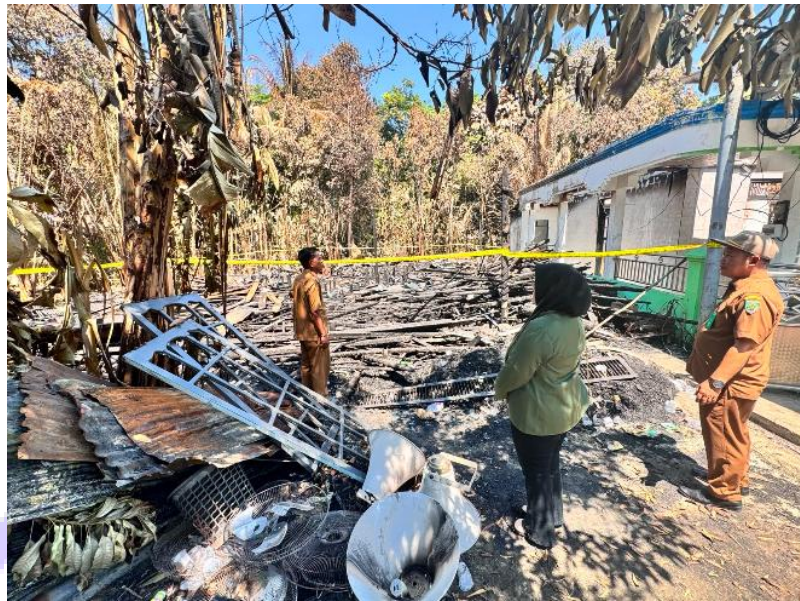
Gambar III- 9 Mencek Kondisi Pasca Kebakaran Tempat Ibadah
