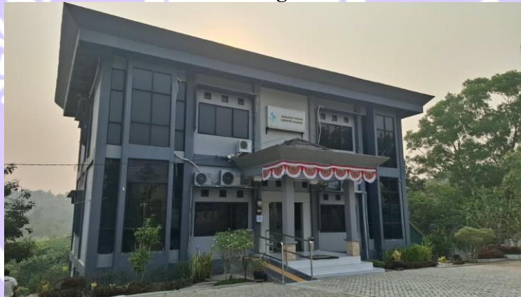
Gambar 2.1 Bangunan Badan Pusat Statistik (BPS) Kabupaten Balangan
