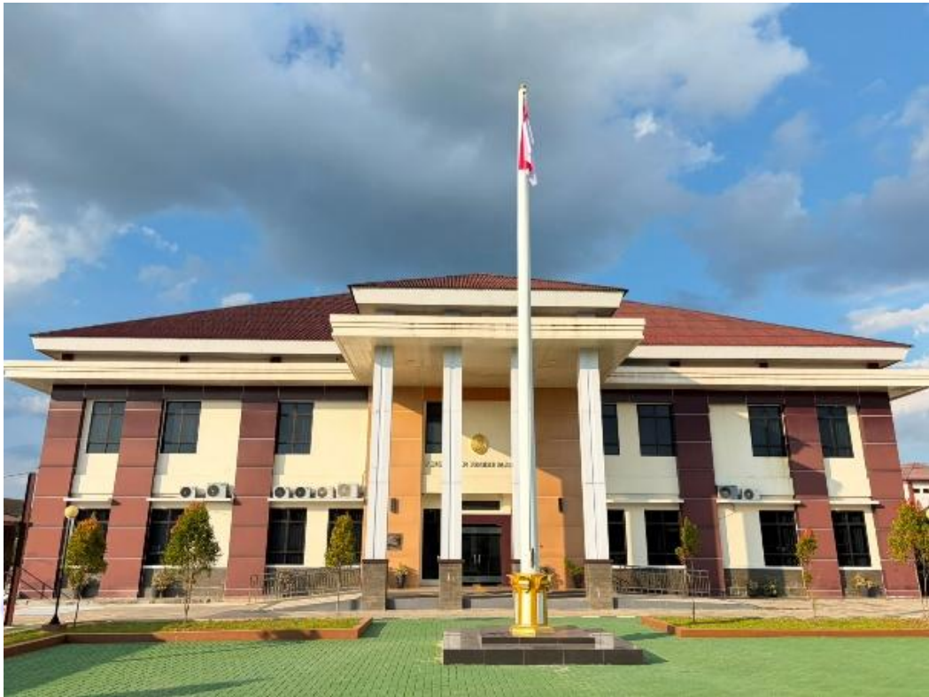
Gambar 2.1 Gedung Pengadilan Negeri Paringin
