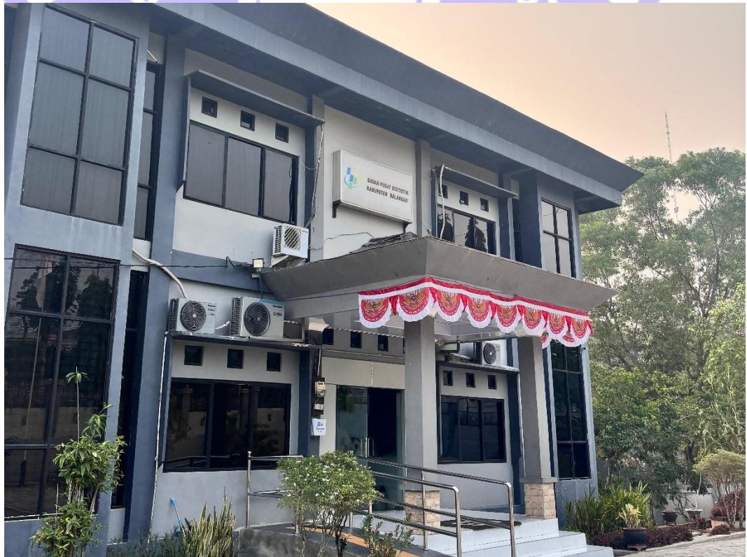
Gambar 2. 1 Bangunan Badan Pusat Statistik (BPS) Kabupaten Balangan
