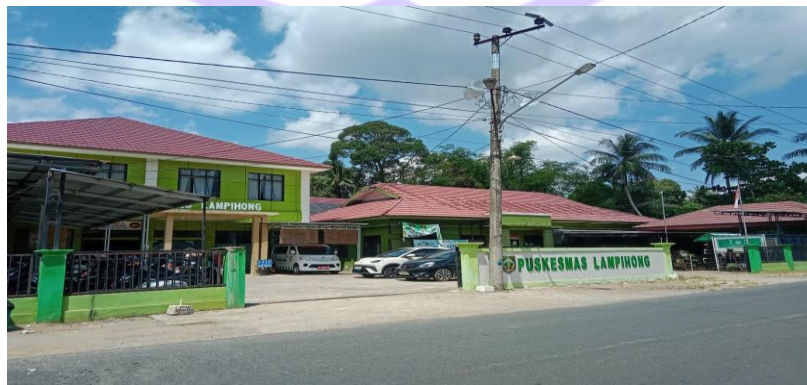
Bangunan UPTD Puskesmas Lampihong
