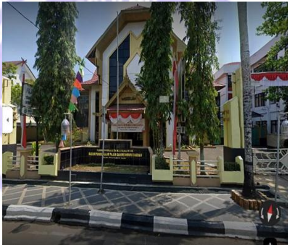
Gambar 2. 1 Kantor Badan Pendapatan Daerah Kabupaten Hulu Sungai Utara
