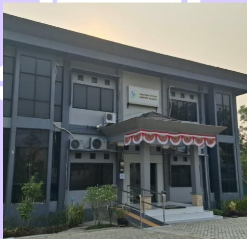
Gambar 2.1 Bangunan Badan Pusat Statistik (BPS) Kabupaten Balangan
