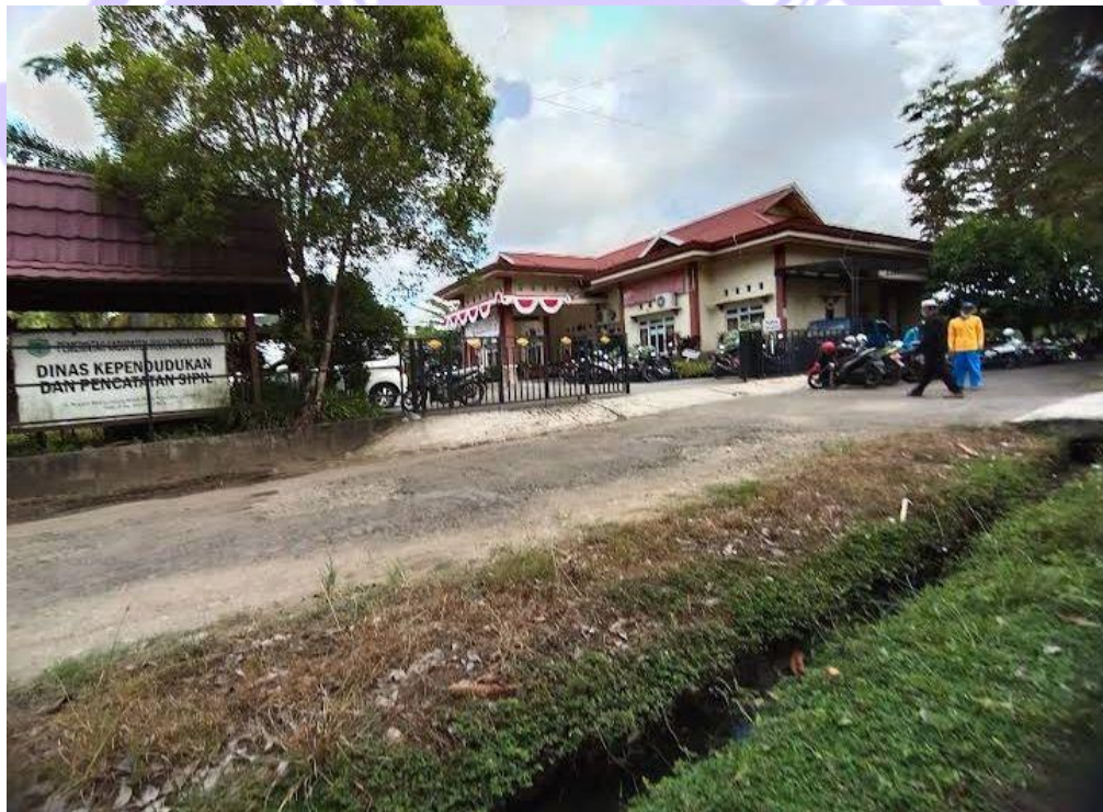
Gambar II-1 Bangunan Dinas Kependudukan dan Pencatatan Sipil
