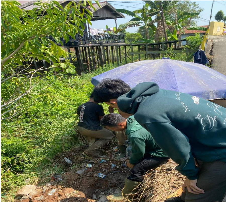
Gambar : Perbaikan Kebocoran Pipa Pelanggan PDAM
