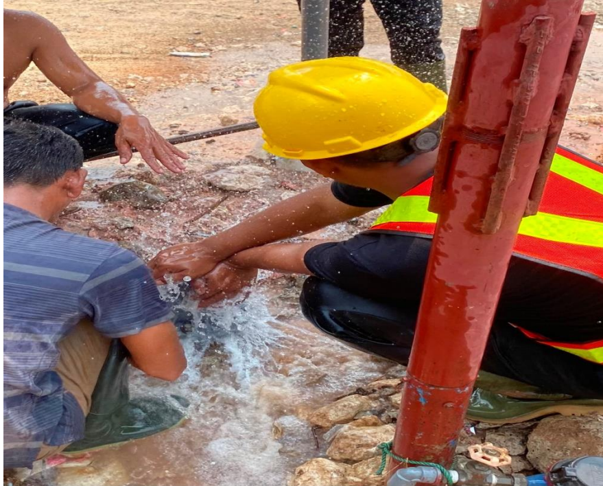
Gambar : Perbaikan komponen Hydrant
