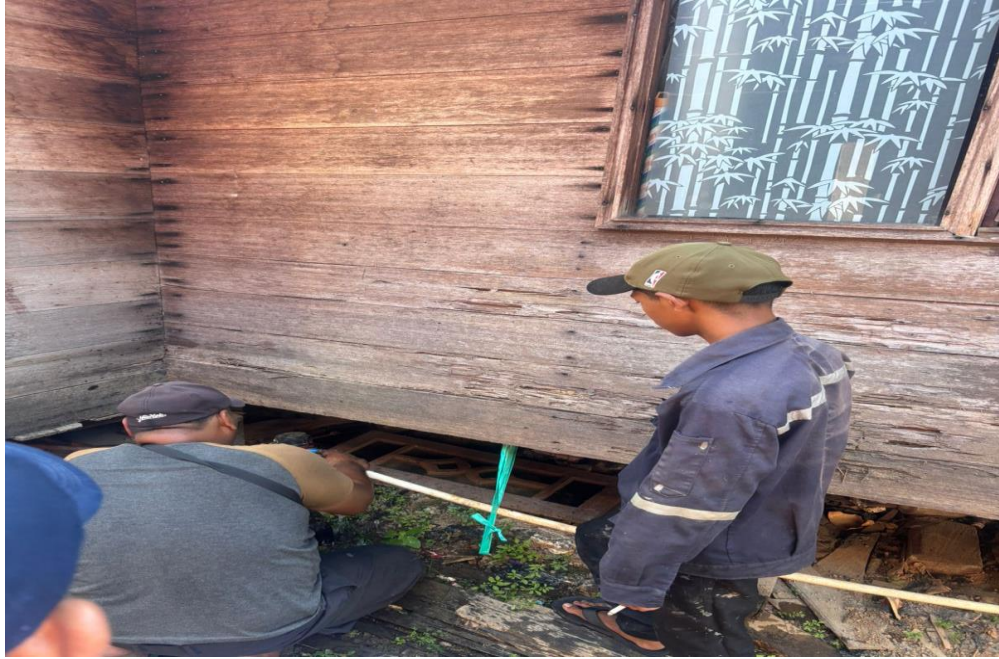
Pengangkatan Meter Yang Tertimbun
