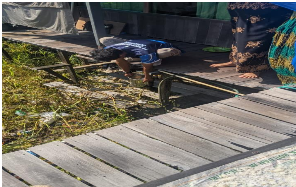
Pengecekan Meter Rusak
