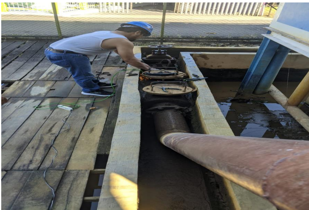
Perbaikan Pipa di Instalasi
