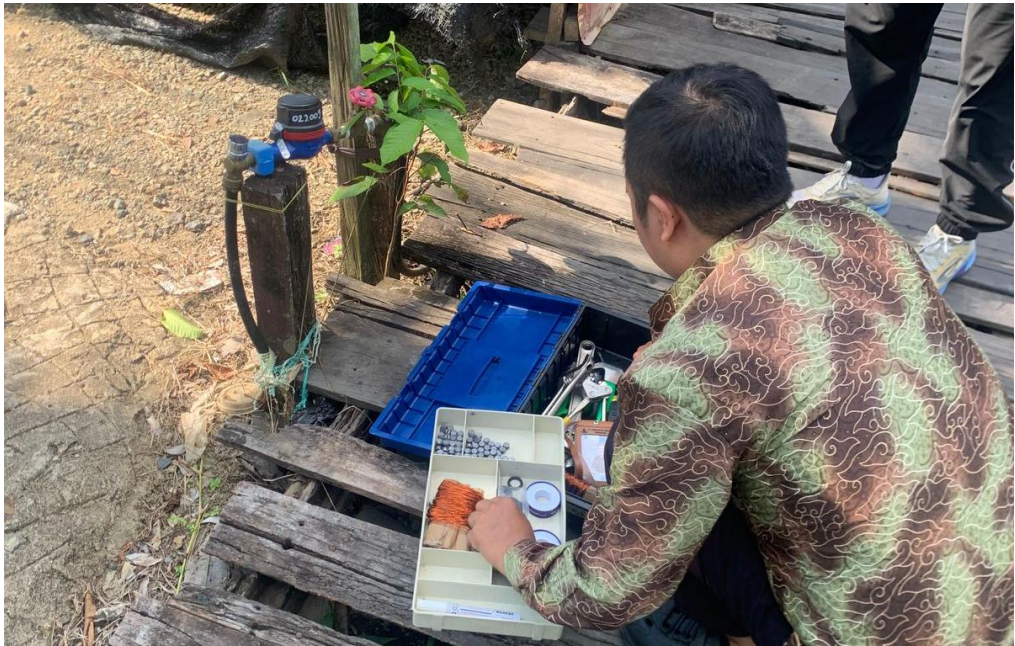
Gambar 5 Menutup Sambungan Leding Rumah
