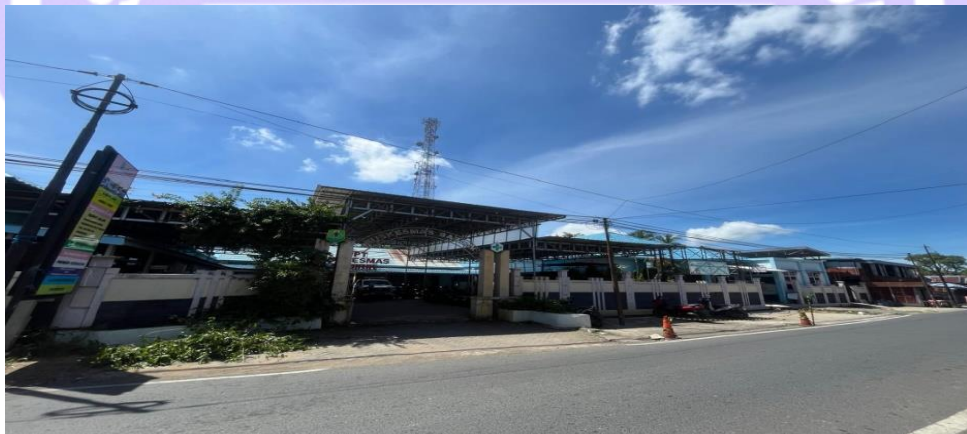
Gambar 2. 1 Bangunan UPT Puskesmas Rawat Inap Babirik
