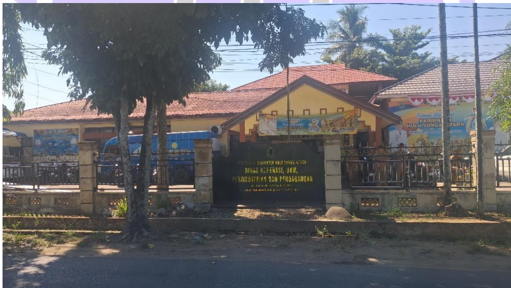
Gambar 2.1 Tampak Depan Dinas Koperasi, Usaha Kecil Menengah, Perindustrian dan Perdagangan Kabupaten Hulu Sungai Utara
