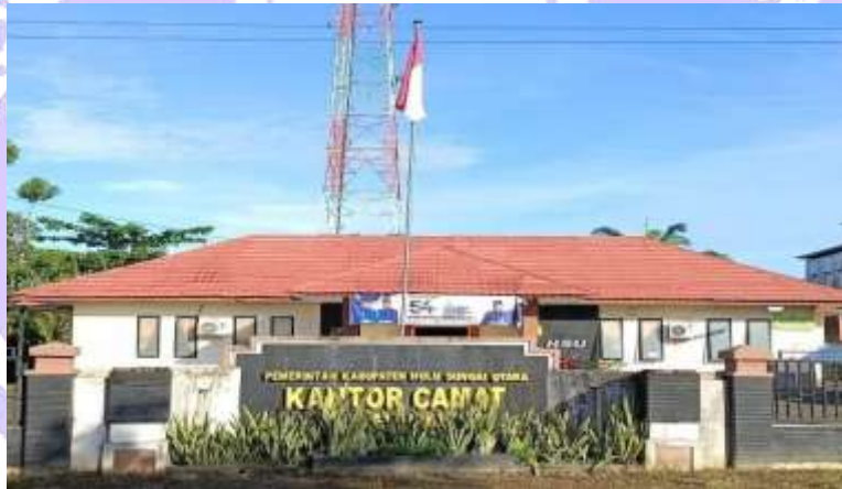
Gambar II- 1 Kantor Kecamatan Babirik Kab. Hulu Sungai Utara
