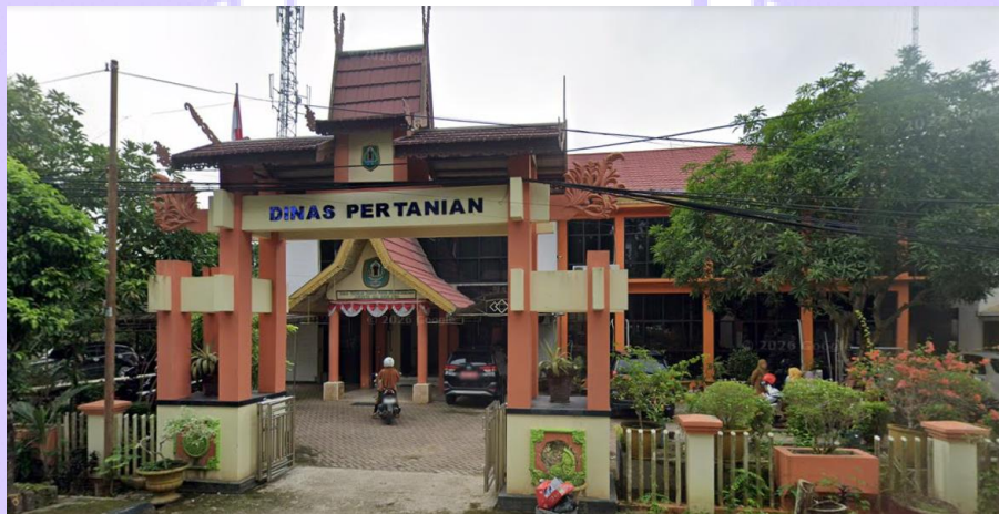
Gambar 2.1 Bangunan Dinas Pertanian Kabupaten Hulu Sungai Utara
