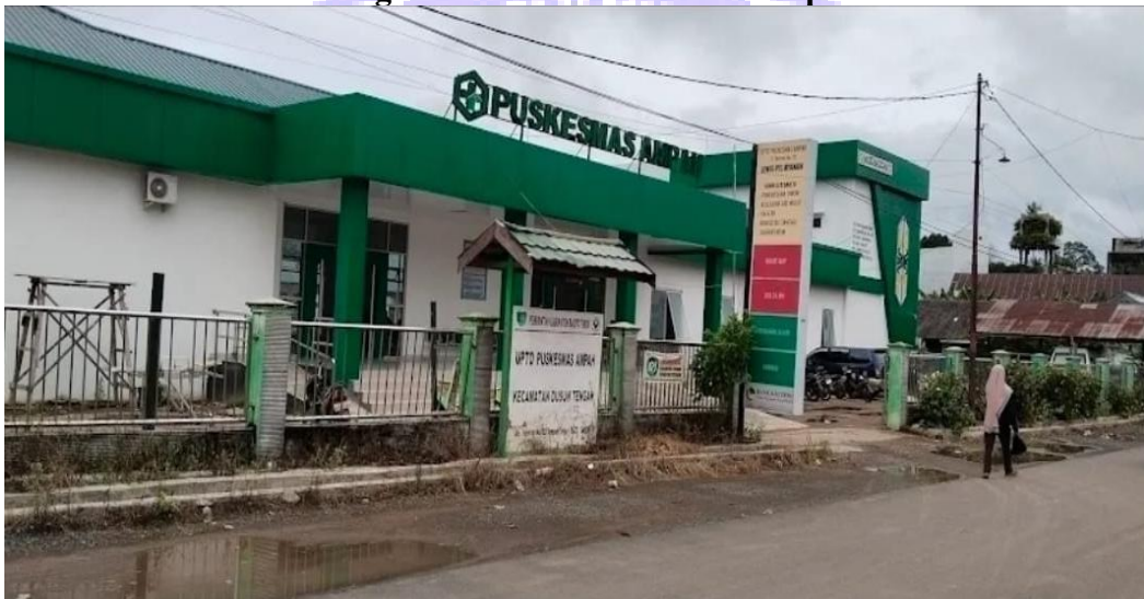
Gambar 2 1 Bangunan UPTD Puskesmas Ampah
